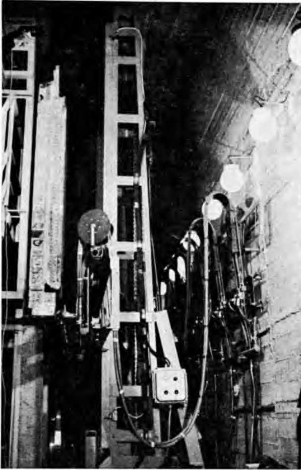
17-9. ábra. Plazmaégőket mozgató berendezés a beégetőtérben
